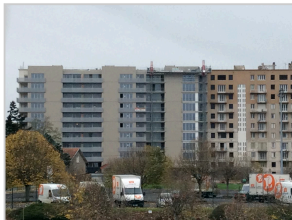
Chantier de la résidence intergénérationnelle
