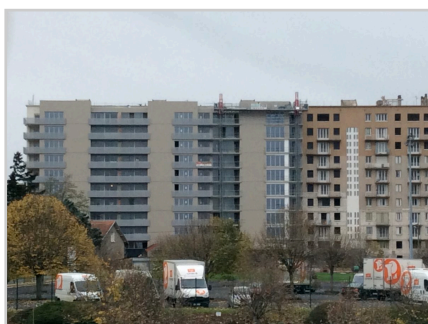
Chantier de la résidence intergénérationnelle
